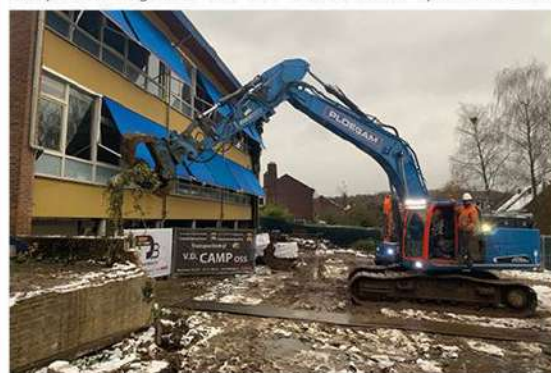
De start van de sloop van GSG Guido.
